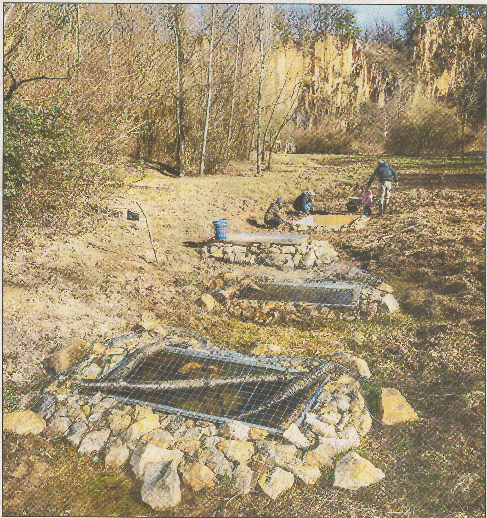
Die Edelstahlwannen wurden in Gruben im Steinbruch Leferenz eingesetzt und mit Wasser befüllt. Die Drahtgitter sollen die Amphibien vor Waschbären schützen. Foto: Alex
