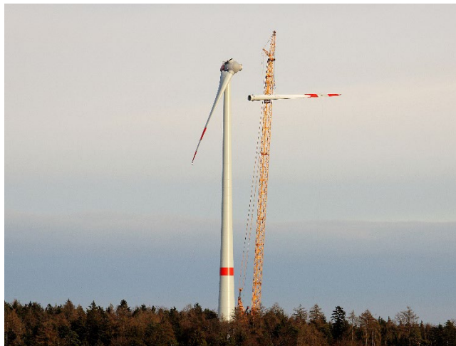
Abbildung 14: Anlagenerrichtung im Windpark Brenntenberg, Landkreis Regensburg (Bayern)
