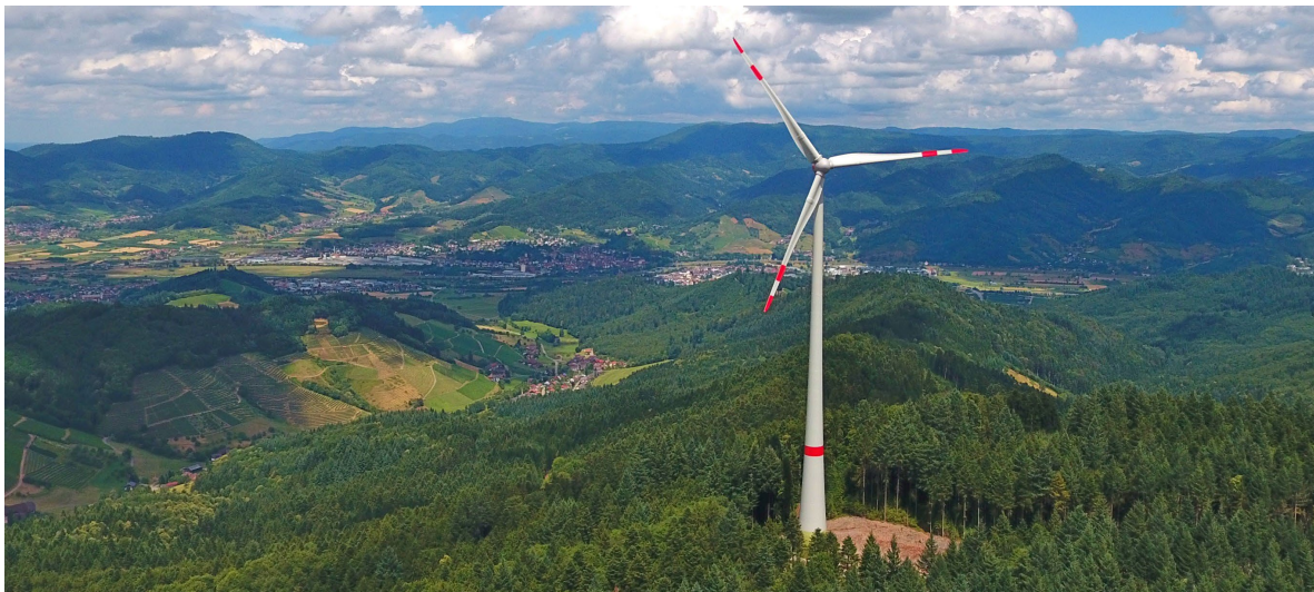
Abbildung 11: Anlage im Windpark Rauhkasten/Steinfirst, Ortenaukreis (Baden-Württemberg)
